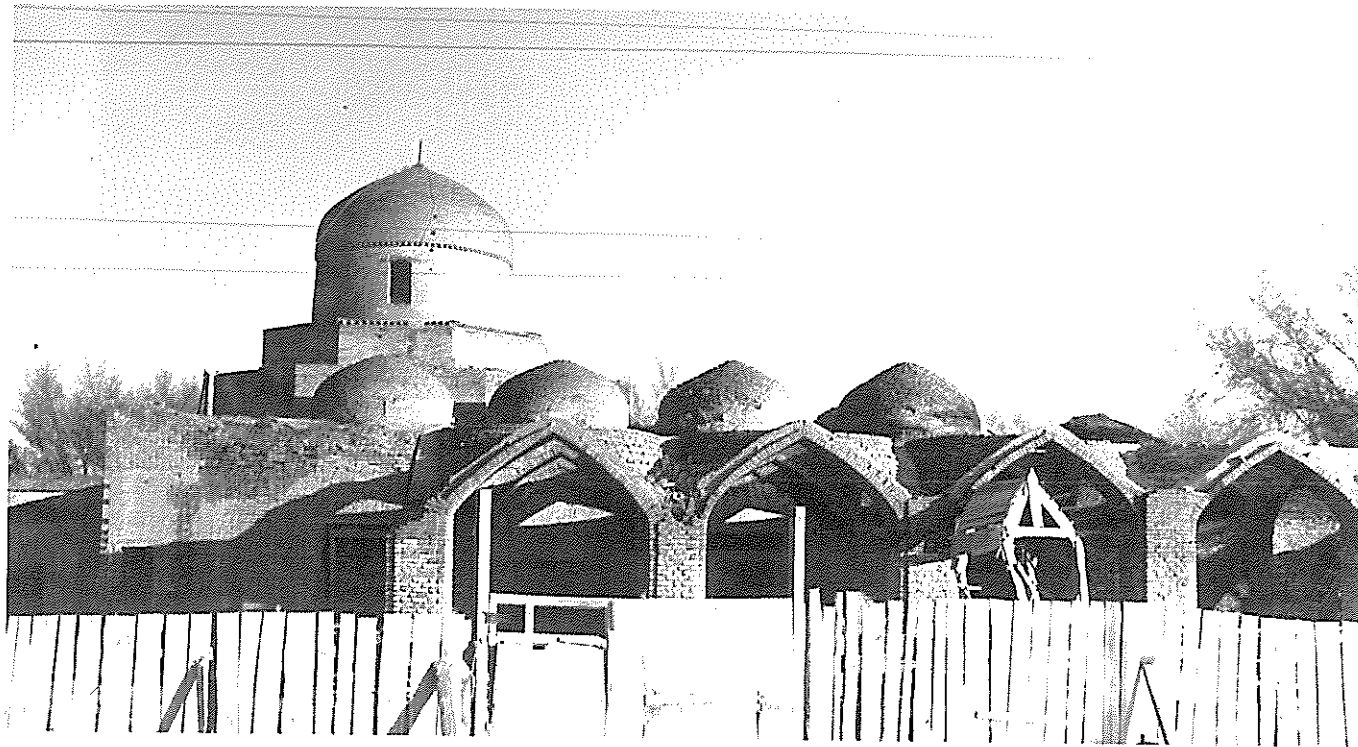
99. Шаян. Мечеть-медресе Аппак-Ишан. Вторая пол. XIX – нач. XX вв. Общий вид мечети. Фото А.П. Рассказова. 1981 г. Shayan. Appak-Ishan mosque-medrese. Second half of 19th – beginning of 20th centuries. General view of the mosque. Photo by A.P. Rasskazov. 1981.
