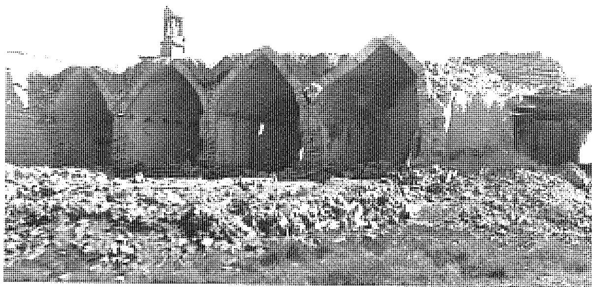
83. Медресе Баба-Ата. Конец XIX – нач. XX вв. Фрагмент полуразрушенного наружного фасада. Фото Б.А. Байтанаева. 1987 г. Baba-Ata medrese. End of 19th – beginning of 20th centuries. Fragment of dilapidated outer facade. Photo by B.A. Baitanayev. 1987.
